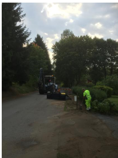
Fiber till Södra Bruksgatan
