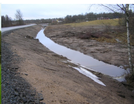
Smedjegatans förlängning med fördröjningsmagasin i Skillingaryd
