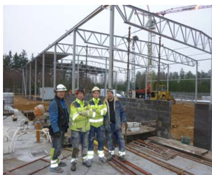
Vaggeryds Energi AB bygger elverksförråd
