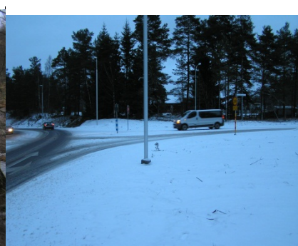
Ny anslutning av Smedbygatan i Vaggeryd efter stängning av plankorsning.
