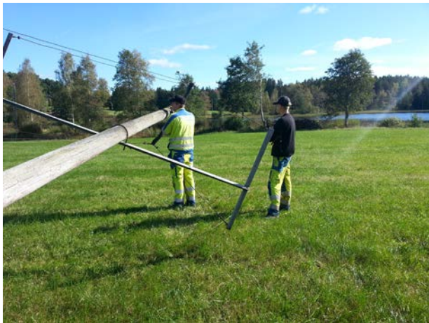
Kablifiering innebär att gamla luftledningarna kan tas ned, här vid Åkers Ryd
