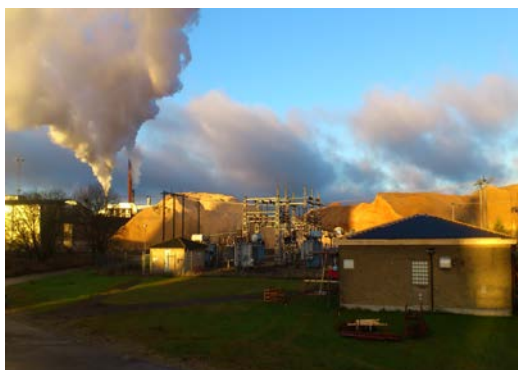
Nytt tak på Stödstorps mottagningsstation
