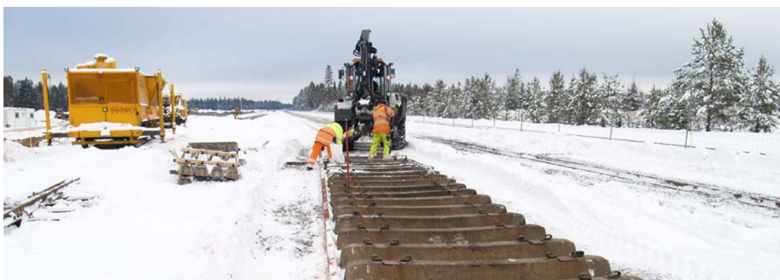
Spårläggning på det nya logistikområdet vid Båråmo utanför Skillingaryd.
