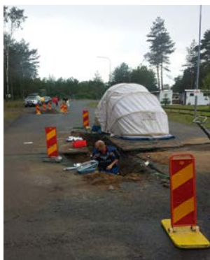
Reparation av skadad fiber
