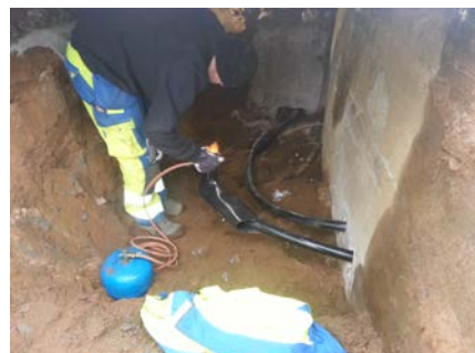
Skarvning av kabel vid vårdcentral i Vaggeryd
