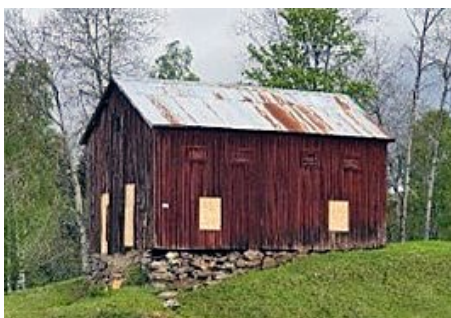
Holma sädesmagasin, Tofteryd. Byggnad med kulturhistoriska värden.
